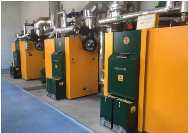
图 7：3 台生物质锅炉并联运行
