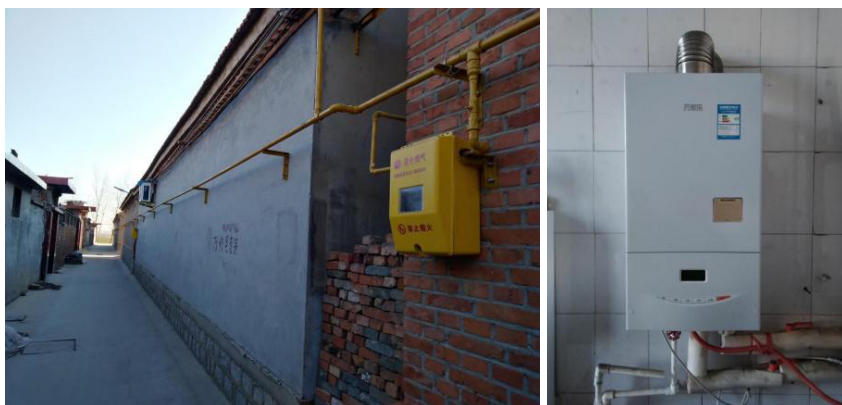
图 1-5：燃气壁挂炉取暖
