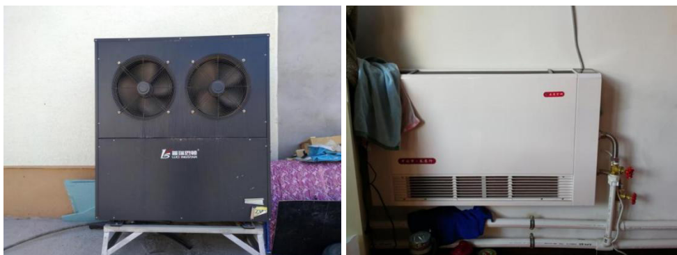
图 1-6：空气源热泵取暖
